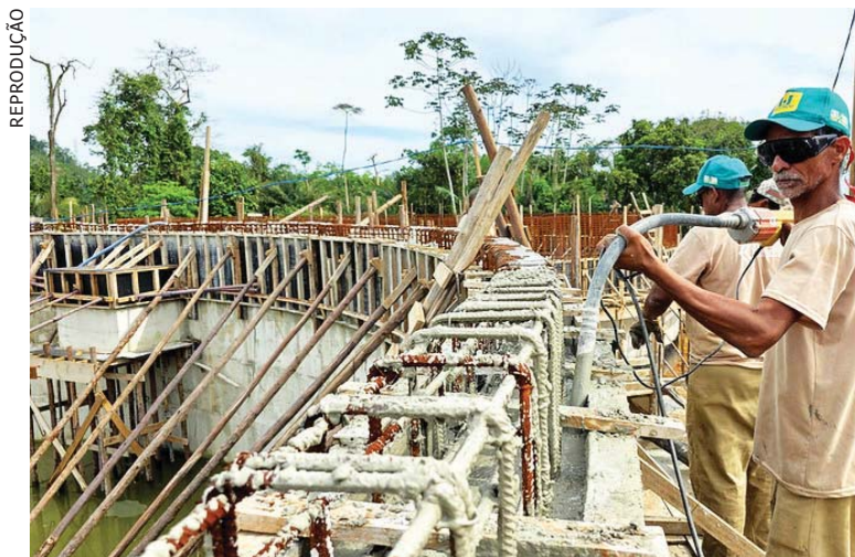
NOVOS reservatórios estão sendo feitos no Bela Vista
