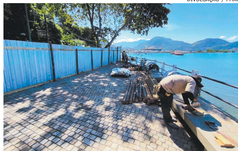
OBRAS no local já começaram e a área está isolada
